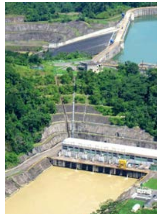
Central Hidroeléctrica Urrá – Fotografía del Archivo: página Urrá generación sostenible.
